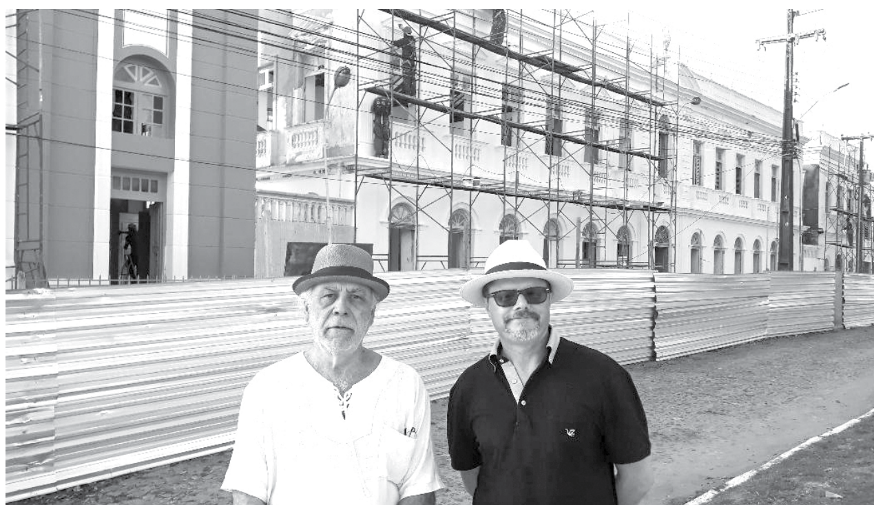
O secretário executivo Rubens Freire e Fabio Naro visitaram as obras da sede do Parque Tecnológico em JP
